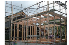
プレカット材住宅建設風景
